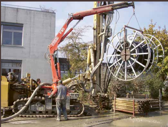
Alternative Energien fördern: Bohrung für eine Erdsonde in Muri 2007.
