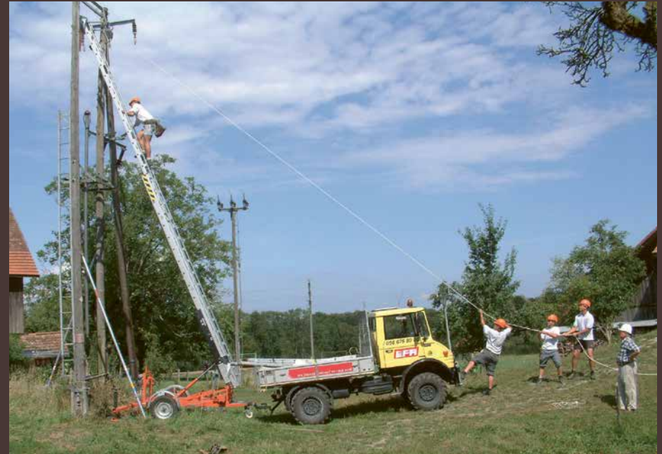
Das Stromnetz verschwindet unter die Erde: Abbruch einer Stangenstation 2003 (oben).
